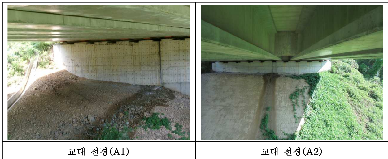
【사진 10.3.31】 교대 전경
