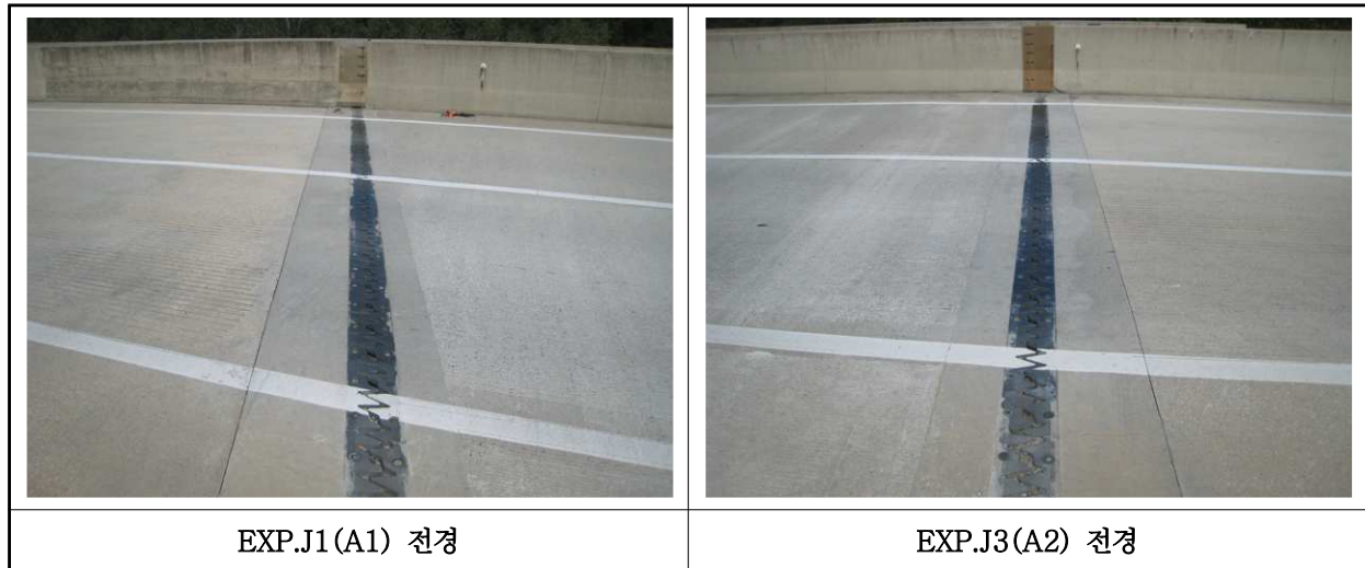
【사진 10.3.39】 신축이음장치 전경
