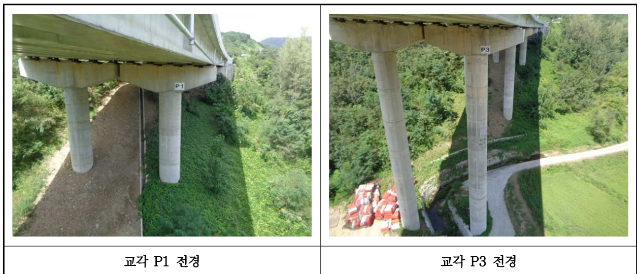
【사진 10.3.10】 교각 전경
