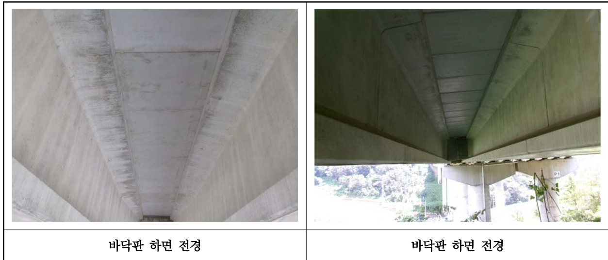
【사진 10.3.2】 바닥판하면 전경
