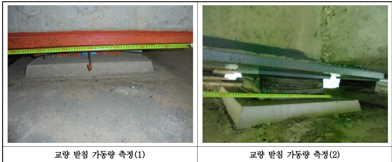
【사진 10.3.38】 교량받침 이동량 측정
