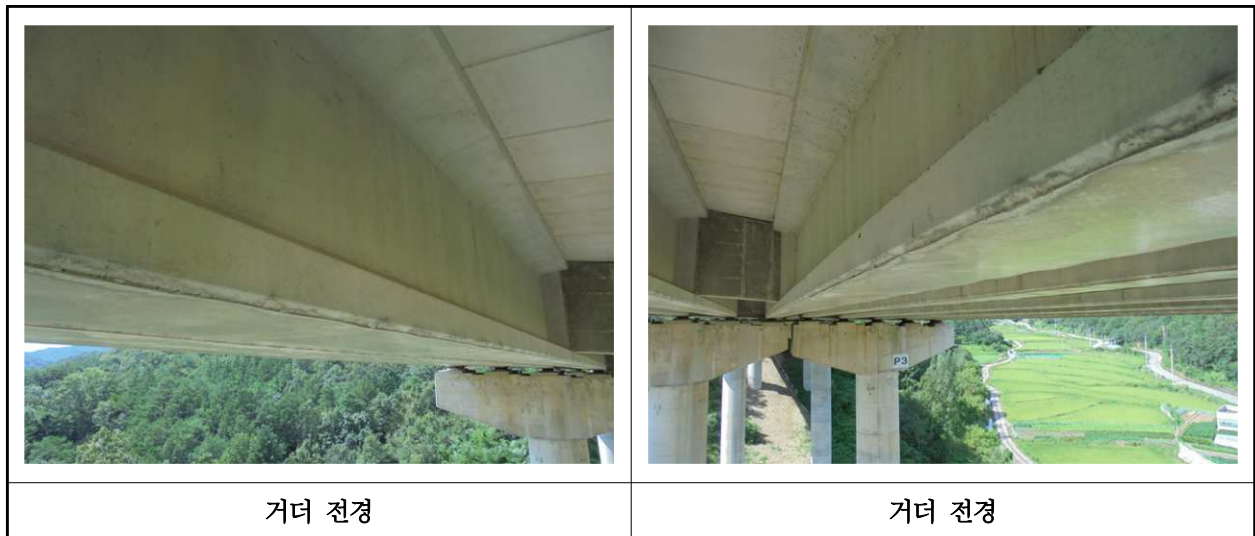
【사진 10.3.27】 거더 전경
