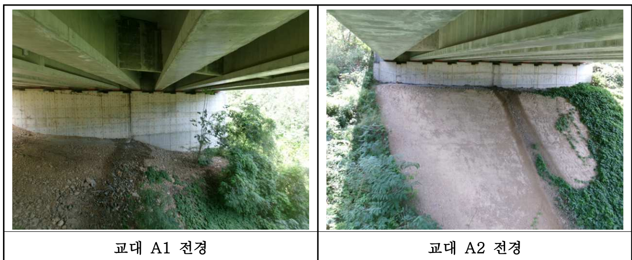
【사진 10.3.8】 교대 전경
