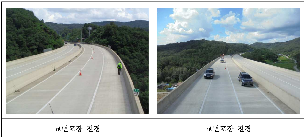
【사진 10.3.42】 교면포장 전경
