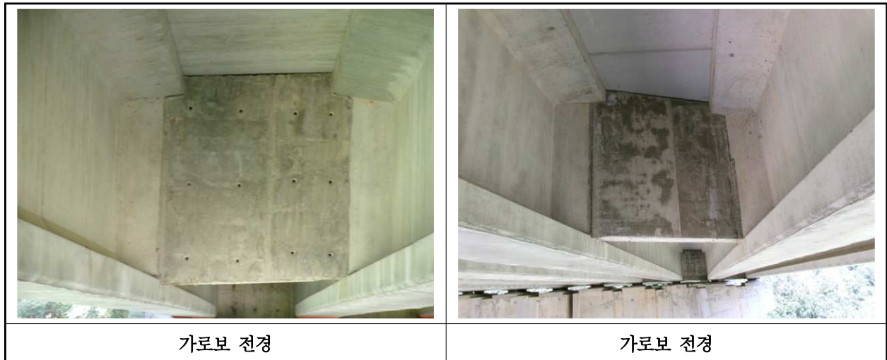
【사진 10.3.6】 가로보 전경
