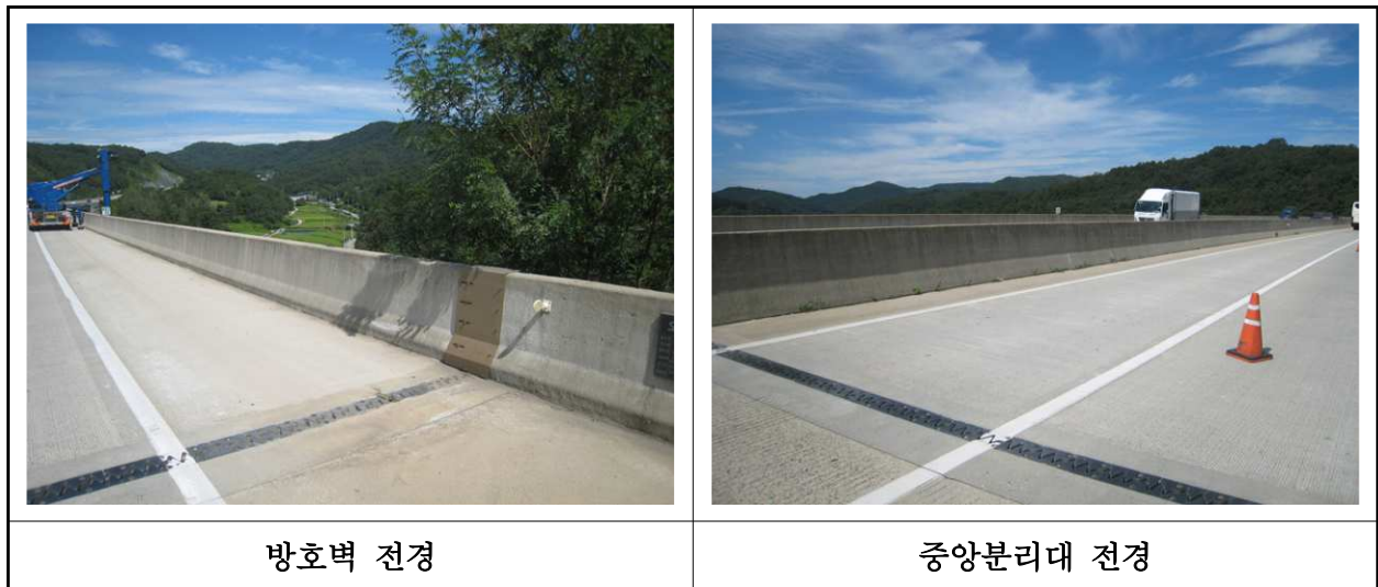
【사진 10.3.23】 방호벽 및 중앙분리대 전경
