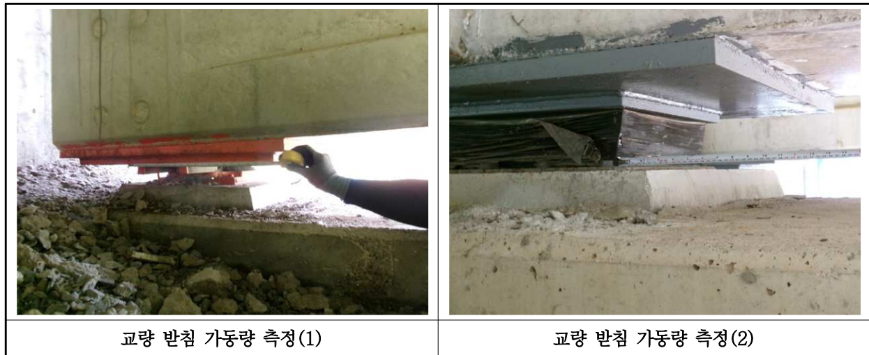
【사진 10.3.15】 교량받침 이동량 측정
