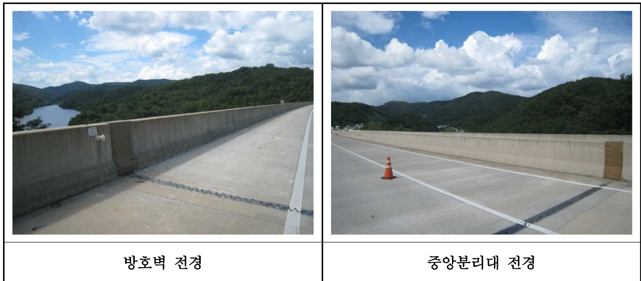
【사진 10.3.46】 방호벽 및 중앙분리대 전경
