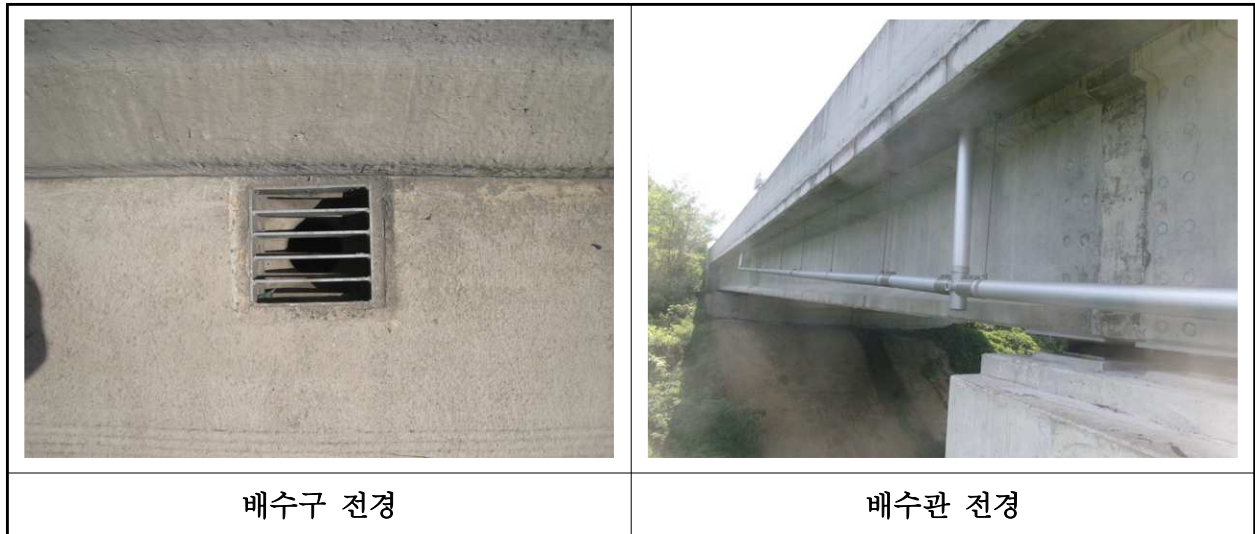
【사진 10.3.21】 배수시설 전경
