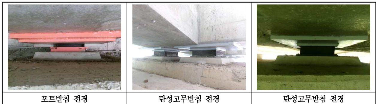
【사진 10.3.12】 교량반침 전경
