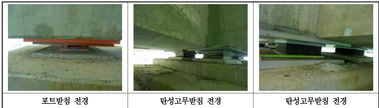
【사진 10.3.35】 교량반침 전경
