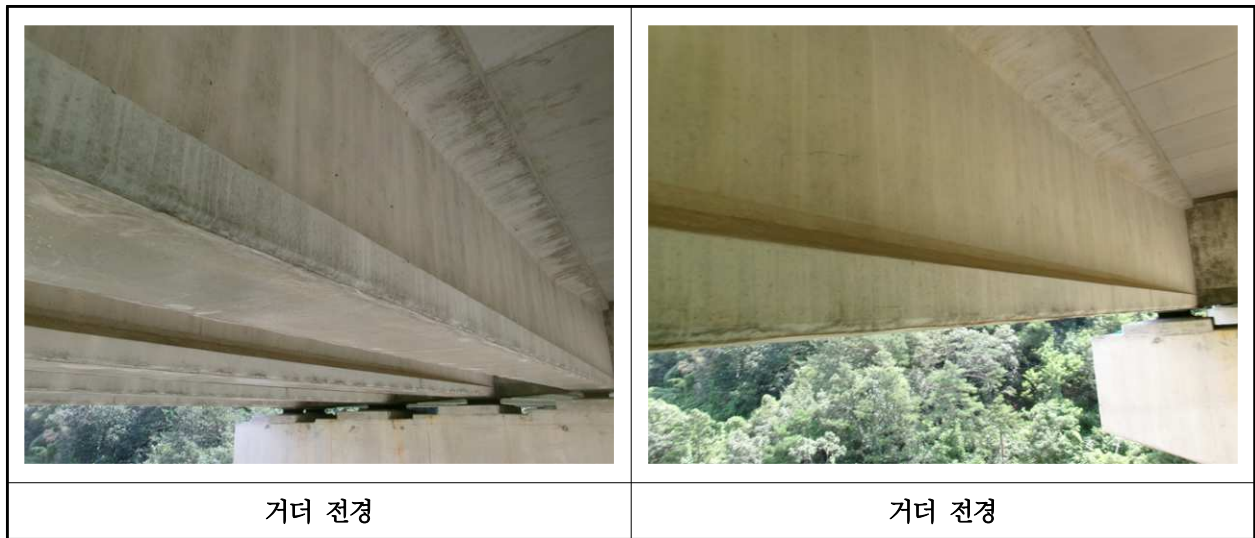
【사진 10.3.4】 거더 전경
