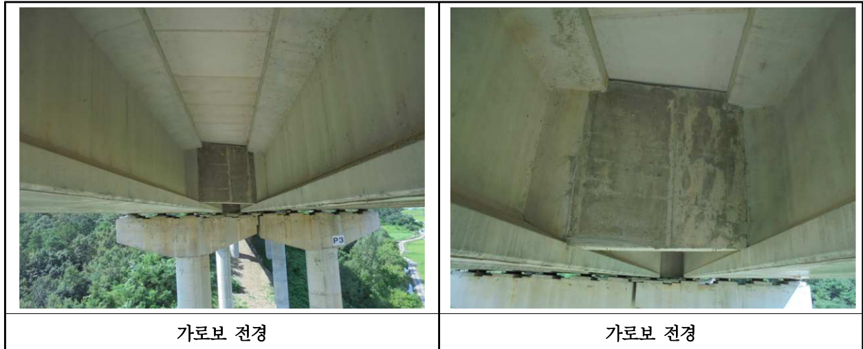
【사진 10.3.29】 가로보 전경
