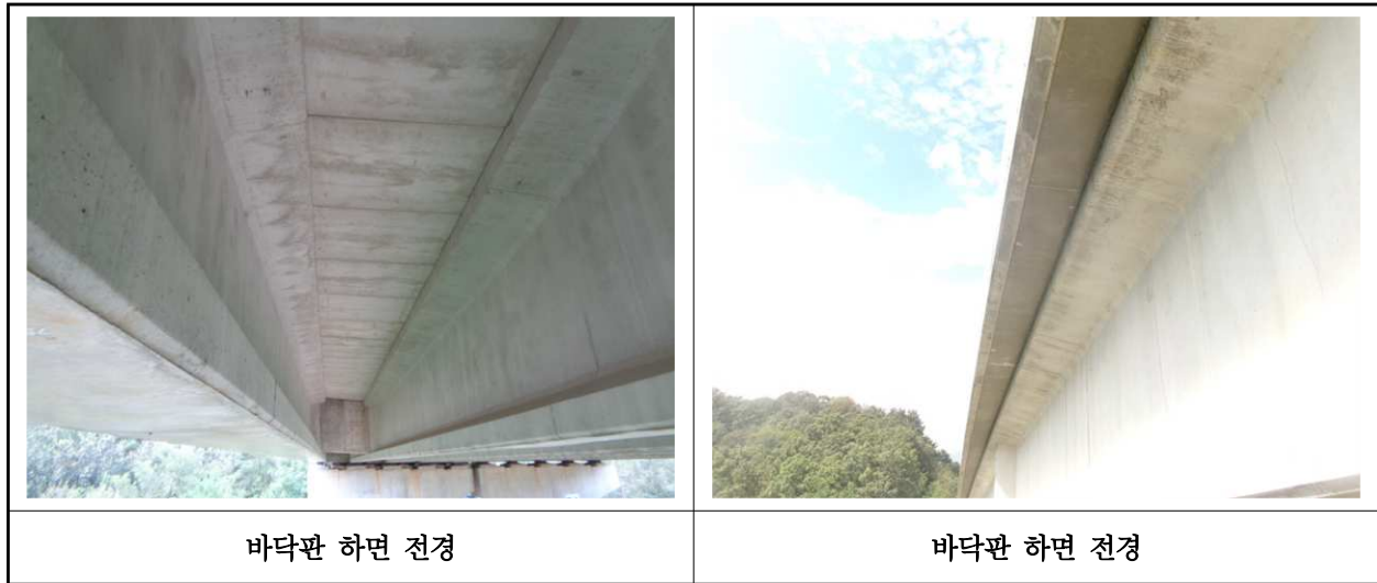
【사진 10.3.25】 바닥판하면 전경
